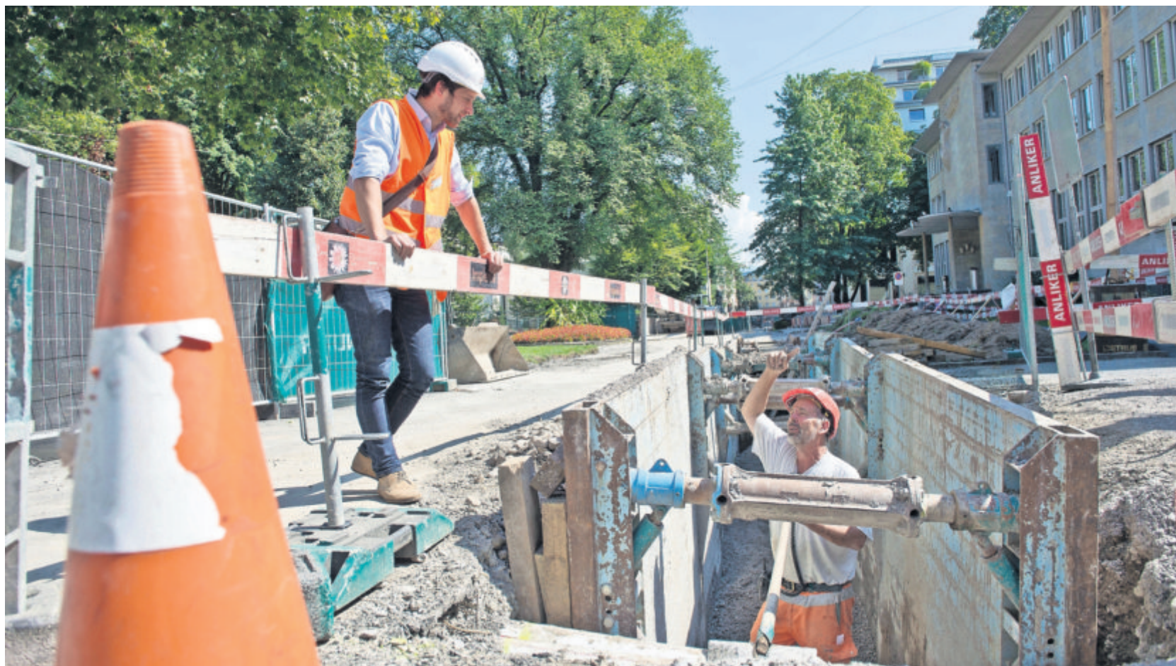
Projektleiter Roger Schürmann (links) begutachtet mit Polier Peter Stadelmann die Baustelle im Hirschmattquartier, wo im Eilzugtempo Leitungen erneuert werden.
