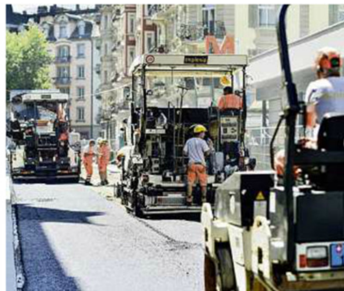
Während der intensiven Bauphase wurde die ganze Winkelriedstrasse zur Baustelle. Alfons Gut
