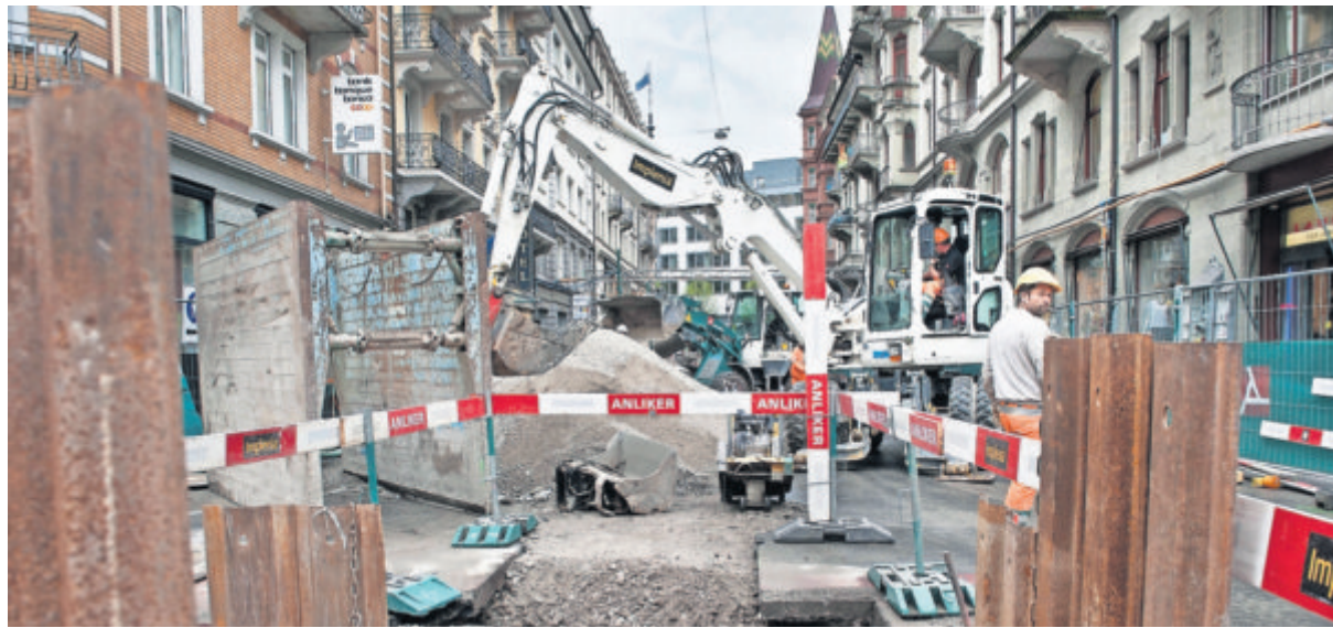
Die Strassen im ganzen Hirschmattquartier werden zurzeit saniert und umgestaltet. Im Bild die Frankenstrasse beim Bahnhof. Bild Boris Bürgisser
