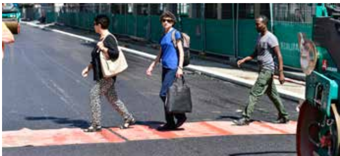
8 | Der Zugang zu den Geschäften musste auch während des Belageinbaus möglichst immer gewährleistet werden (Foto: Alfons Gut). 8 | Il a fallu garantir l'accès quasi-permanent aux commerces, même pendant la pose du revêtement (photo: Alfons Gut).
