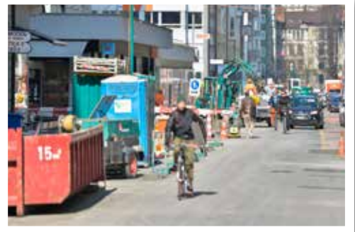
5 | Die Vorarbeiten fanden teilweise unter anforderungsreichen Bedingungen im normalen Verkehr statt (Foto: Alfons Gut). 5 | Certains travaux préparatoires ont eu lieu dans des conditions très exigeantes, avec une circulation normale (photo: Alfons Gut).
