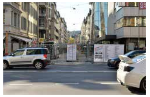
6 | Die Winkelriedstrasse war während etwas mehr als zwei Monaten gesperrt (Foto: Alfons Gut). 6 | La Winkelriedstrasse a été fermée au trafic pendant un peu plus de deux mois (photo: Alfons Gut).
